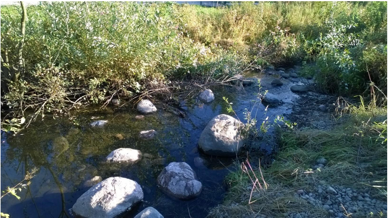
kuva 4: Kosken niska kunnostuksen jälkeen. Soraikko on paksuudeltaan keskimäärin 30 cm. Pituutta on noin 5 metriä.
