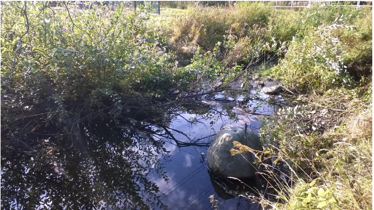
kuva 3: Kosken niska ennen kunnostusta.
